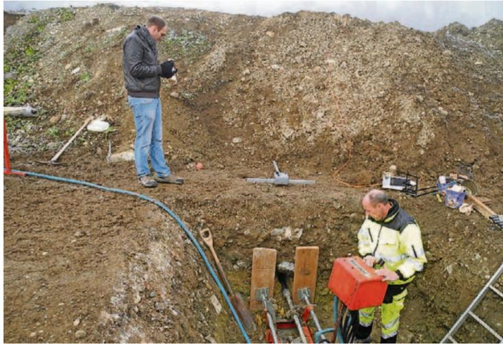
Der Sensor auf dem Boden misst das Magnetfeld des Bohrkopfs und sendet die Daten an das Tablet, das Oliver Oggenfuss (links) in der Hand hält.
